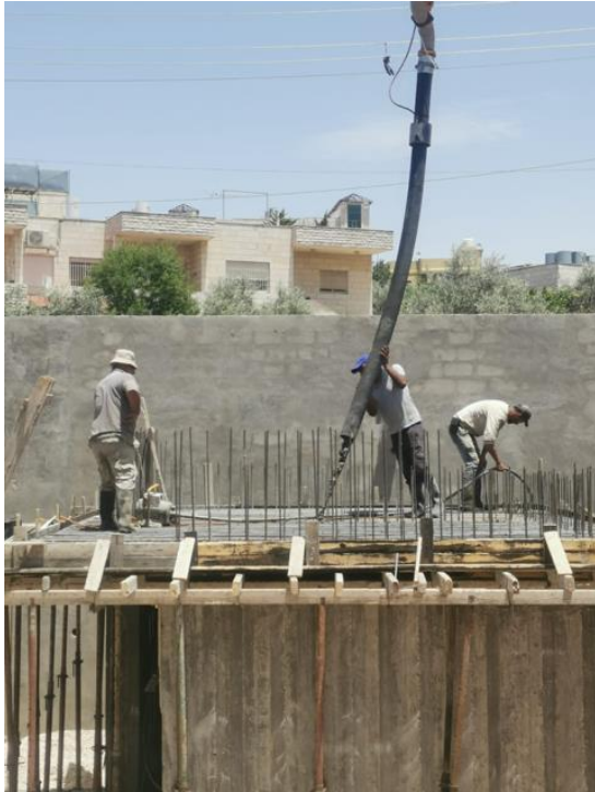
Die Decke des Schutzraumes wird betoniert
