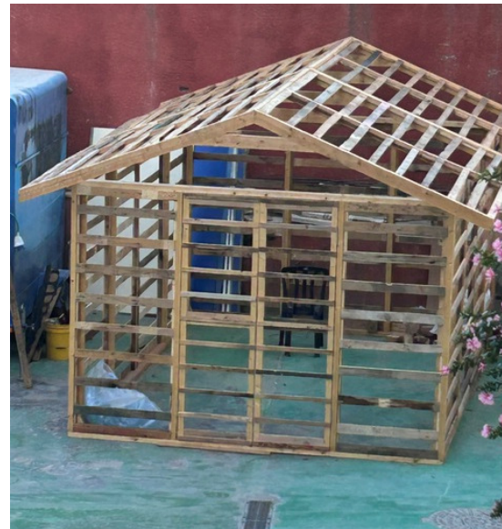
Ein weiteres Gewächshaus wird bei LIFEGATE aus alten Holzpaletten zusammengebaut
