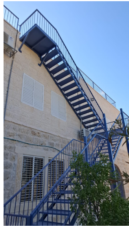
Treppe als Fluchtweg bei Feuer
