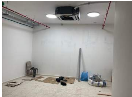
Klimaanlage wird in den Schutzräumen installiert
