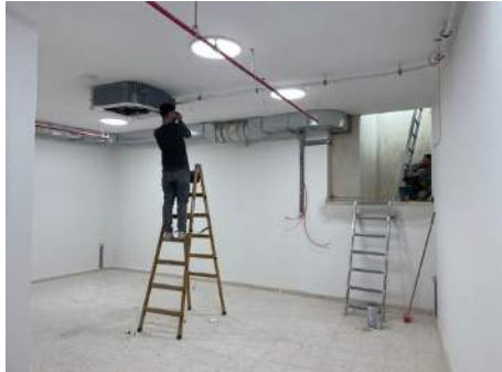
Klimaanlage wird in den Schutzräumen installiert
